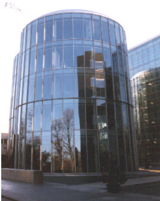
Bild 1 Vollverglaste Fassaden sind 'in', thermisch sind sie aber eher problematisch (alle Photos: D. Hennings)
