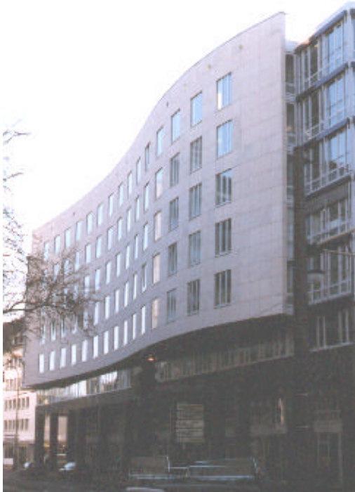
Bild 2 Lochfassaden erleichtern es, Bürogebäude thermisch und energetisch zu optimieren.
