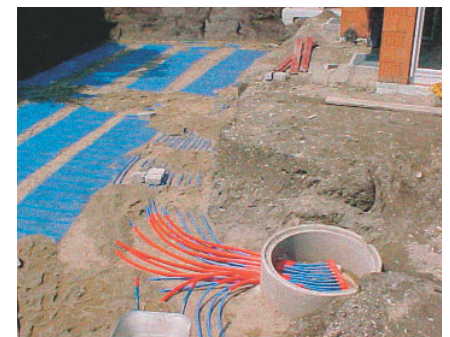
Einbau eines Kapillarrohrmatten-Erdwärmekollektors bei einem Neubauprojekt.
