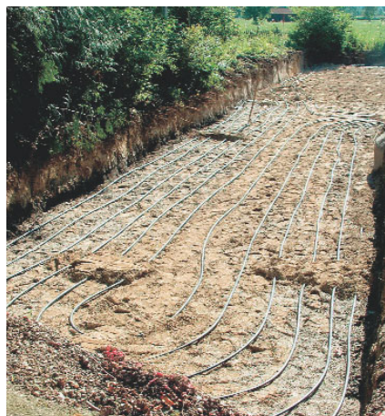
Einbau eines Kapillarrohrmatten-Erdwärmekollektors bei einem Neubauprojekt.
