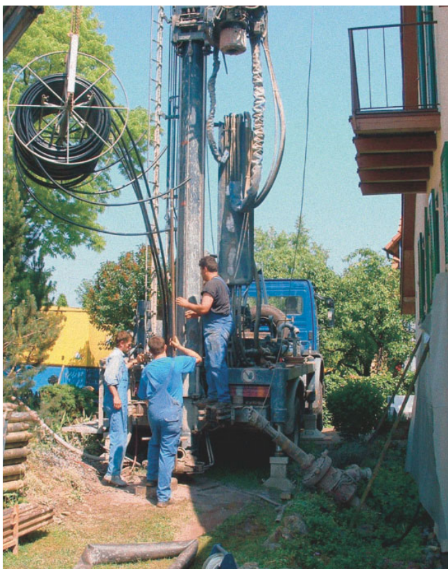
Bohrarbeiten für eine Erdwärmesonde an einem Einfamilienhaus.
