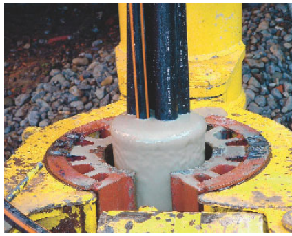
Zementation der eingebauten Doppel-U-Erdwärmesonde.
